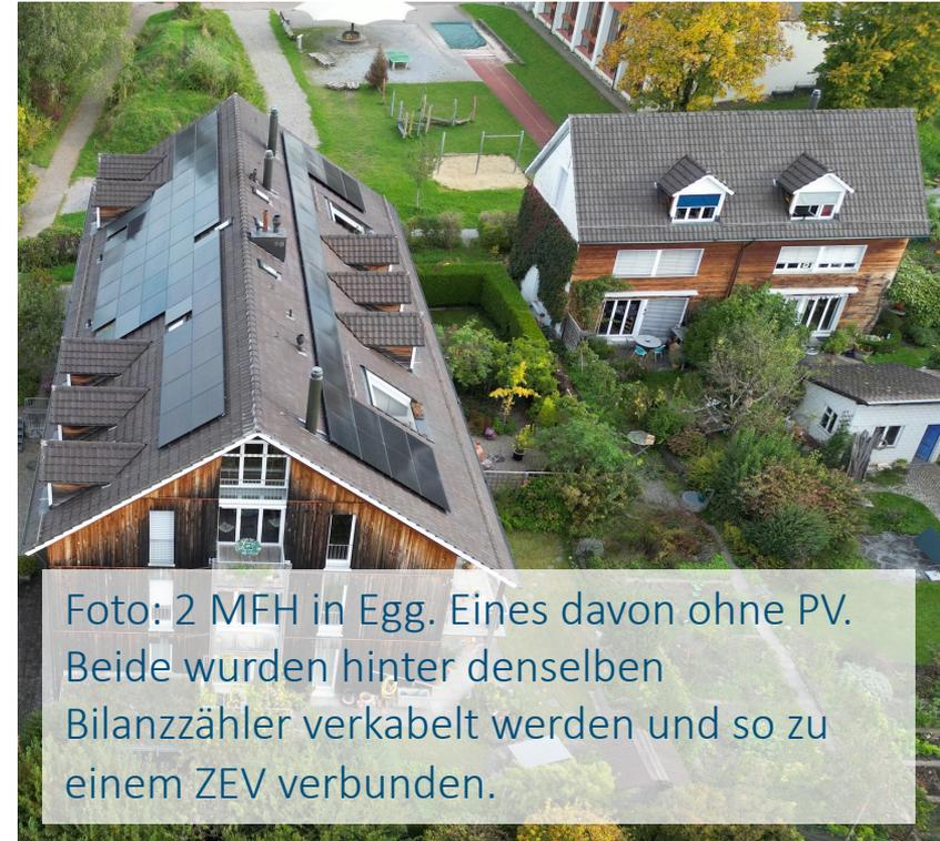
Foto: 2 MFH in Egg. Eines davon ohne PV. Beide wurden hinter denselben Bilanzzähler verkabelt werden und so zu einem ZEV verbunden.
